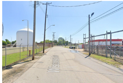
Instalación industrial en Riverside
