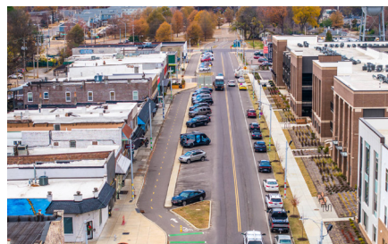
Calle principal de poca altura: Avenida Amplia
