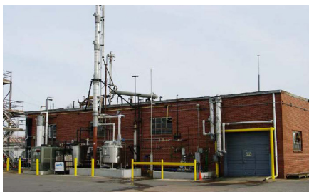
Instalación de fabricación en Chelsea Ave
